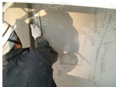
ボンドカーボピンネット工法(左) / 鉄骨ブレース接着工法(右)
